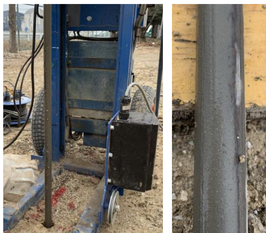
図 4.14 液状化層のロッドの引抜き状況の例(No.06 亘理)
