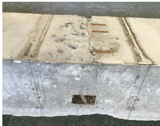
写真-3.5.2.1 載荷試験後の試験体状況
