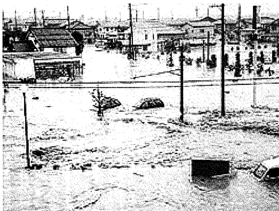
新潟豪雨時の被災状況（名木野小学校：見附市）
