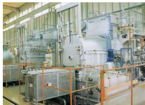
図 3.13 ガス浸炭窒化炉 Gross 1 ton
