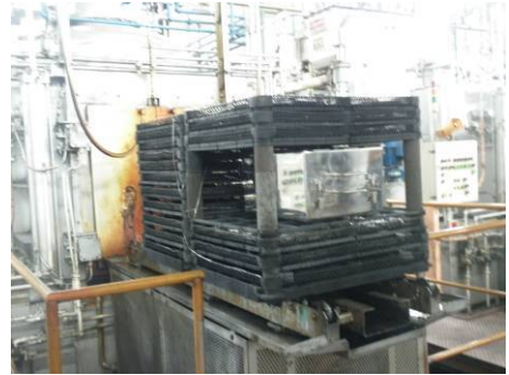
図 2.4 炉内温度分布測定状況
