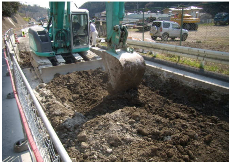
写真 4-1 土と改良材を混合している様子
