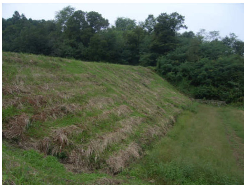
写真 3-1 堤体の下流側のり面
