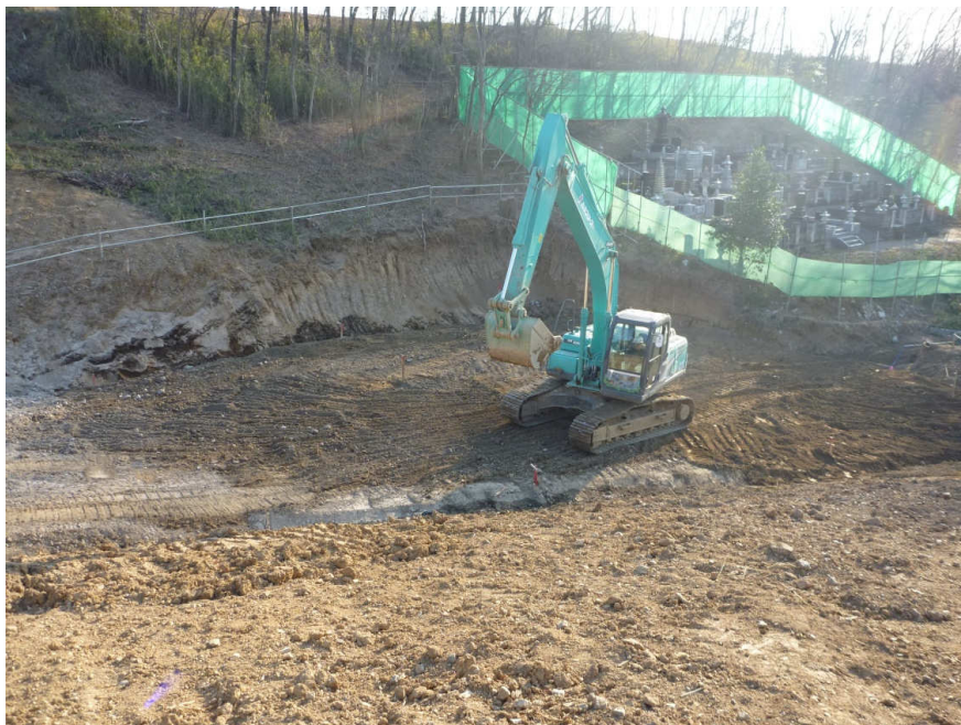
写真 2-10 実施工での転圧の様子
