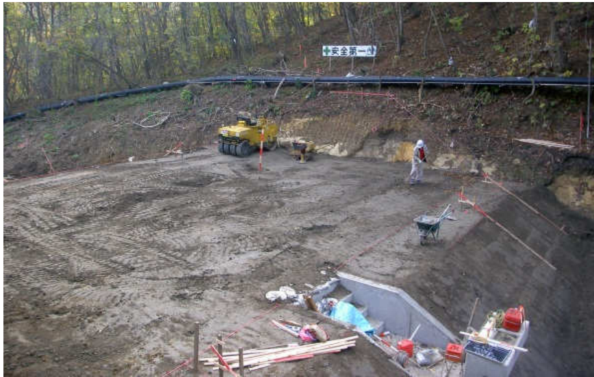
写真 2-12 施工中の堤体
