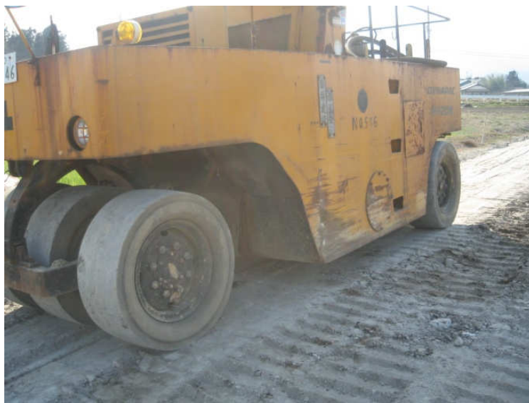
写真 4-2 施工写真 改良後の転圧状況
