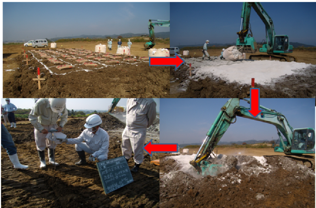
写真 2-7 試験施工の様子とコーン貫入試験による強度測定
