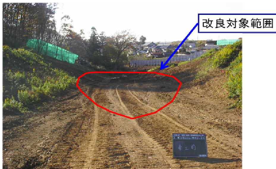
写真 2-8 施工前の施工箇所
