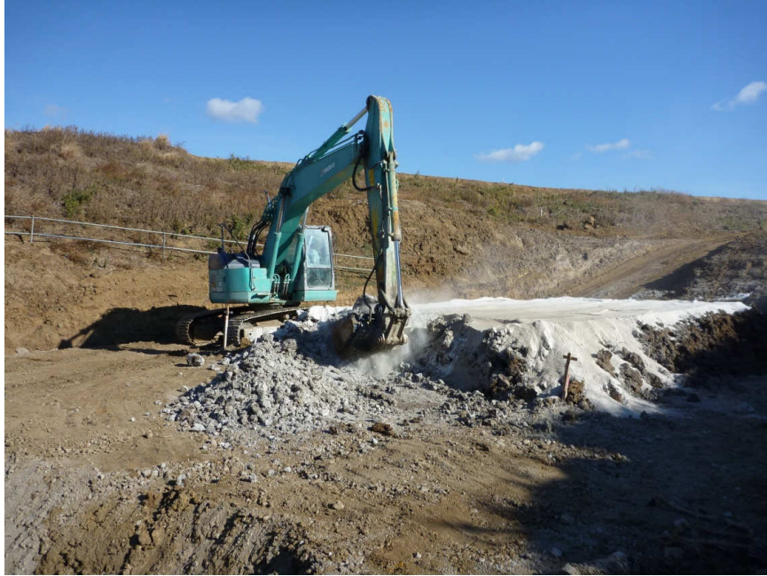
写真 2-9 実施工での混合攪拌の様子
