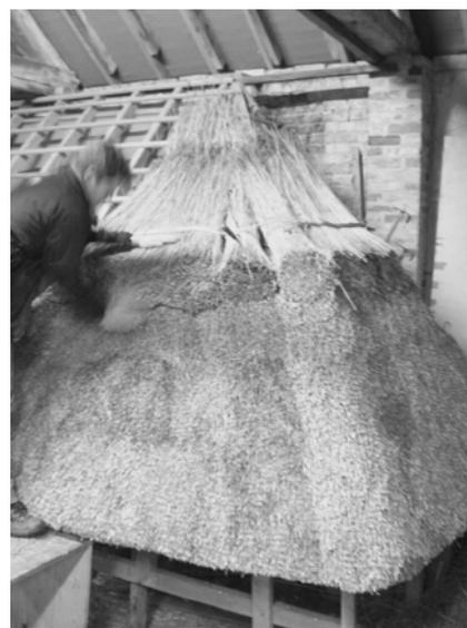
写真7 葦を使って棟端を葺く
