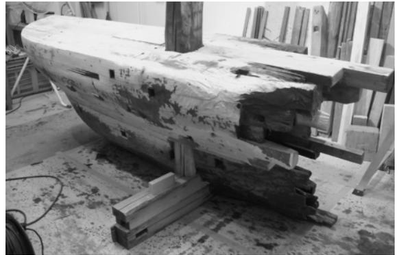
写真37 柱は側面を破り外に出て床に達している
