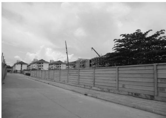
写真3 入口から集合住宅をみる
