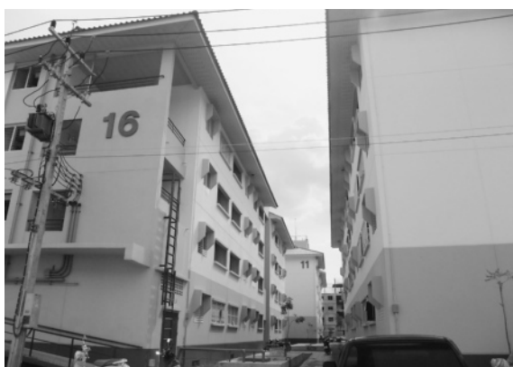
写真5 1階住戸へのアクセススロープ、住棟間共用スペース
