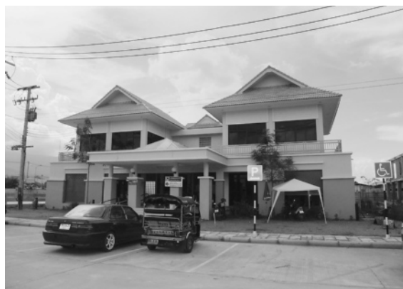
写真2 現地販売事務所
