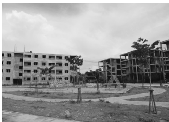
写真6 未完成のままの集合住宅と公園
