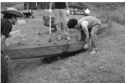
写真28 角度を調整しながら埋設
