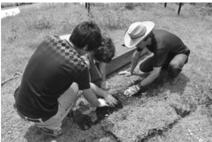
写真27 表土を取り除き設置の穴を掘る
