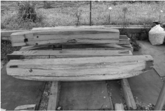
写真20 材②による制作（手前）
