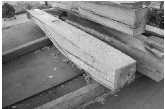
写真23 材⑤ 底面を大きく切削
