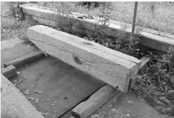
写真22 材④ 短いが埋設させることで対応
