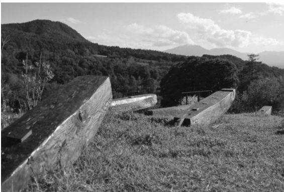
写真33 作品部分 (材④付近から見る)
