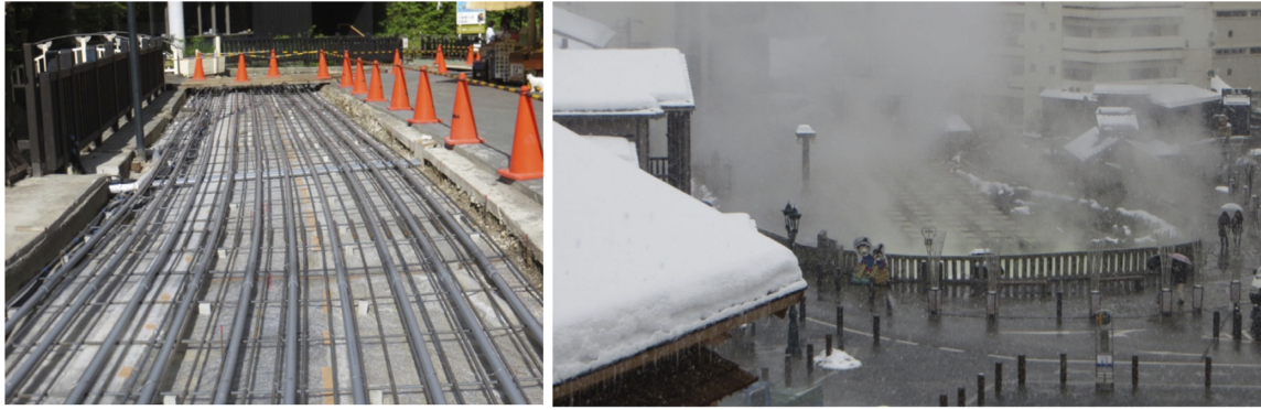
図6 温泉熱を利用した道路融雪 左：融雪パイプを埋め込む工事（2016年6月筆者撮影） 右：屋根には積雪があるが湯畑周辺の道路にはない（2016年1月撮影）
