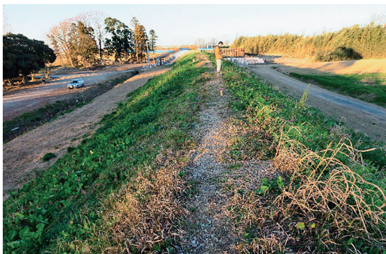
図7 都幾川右岸決壊地点周辺に残存していた「弱小堤」(A)と堤防拡幅区間(B)、2019年12月青山撮影。
