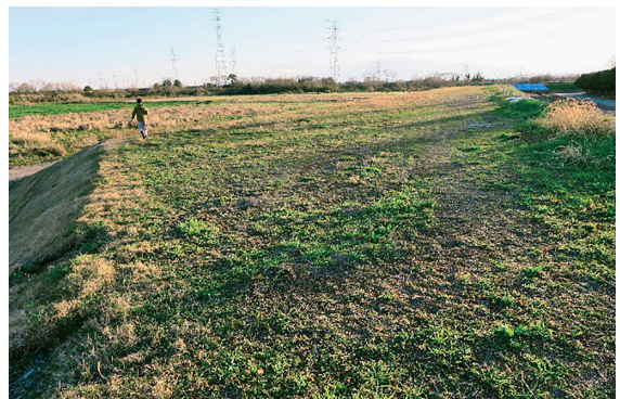
図7 都幾川右岸決壊地点周辺に残存していた「弱小堤」(A)と堤防拡幅区間(B)、2019年12月青山撮影。
